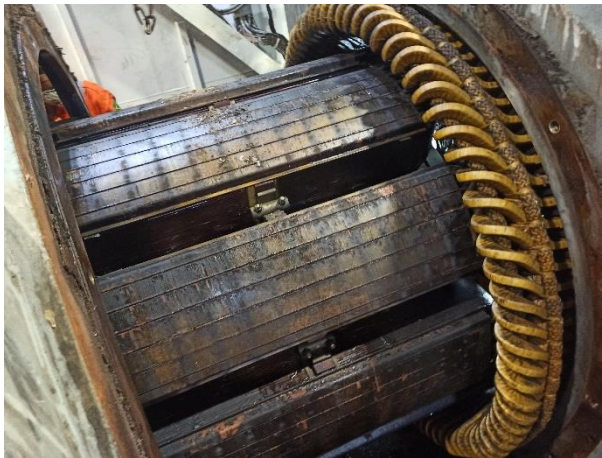
Rotor principal antes e após da limpeza com gelo seco e pintura
