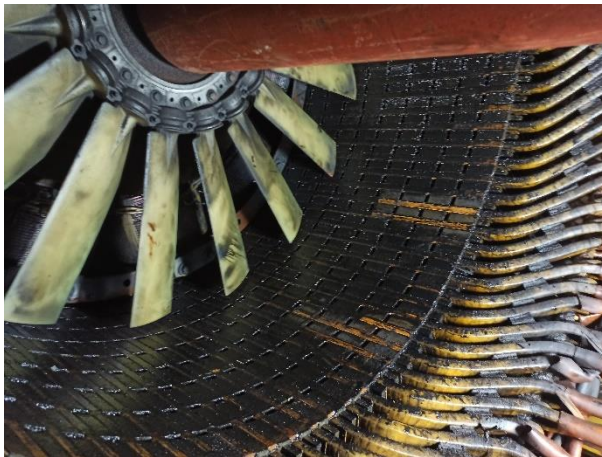
Estator antes e após limpeza com gelo seco e aplicação de verniz
