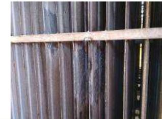
Pontos de vazamento devido a oxidação após limpeza e aplicação de solda fria
